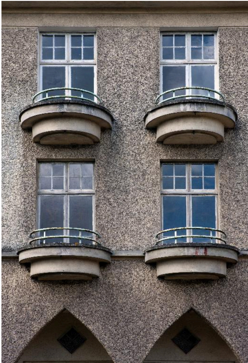
Ancien hôpital militaire réhabilité dans le projet de Grand Hôtel ; détail de l'élévation postérieure.
