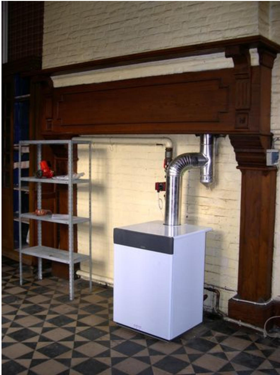
Intérieur, rez-de-chaussée, pièce sud-est : manteau de cheminée.
