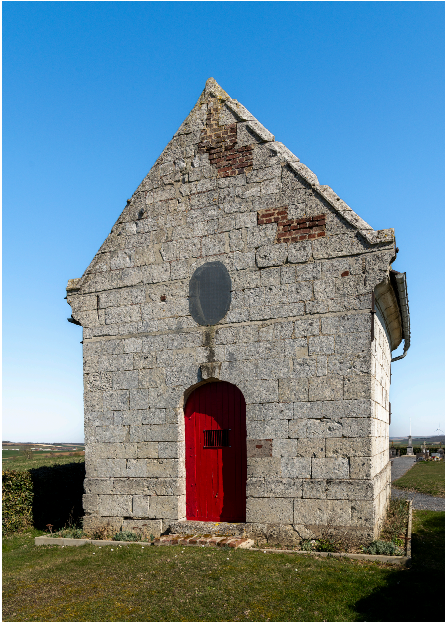
Vue générale de la façade occidentale.
