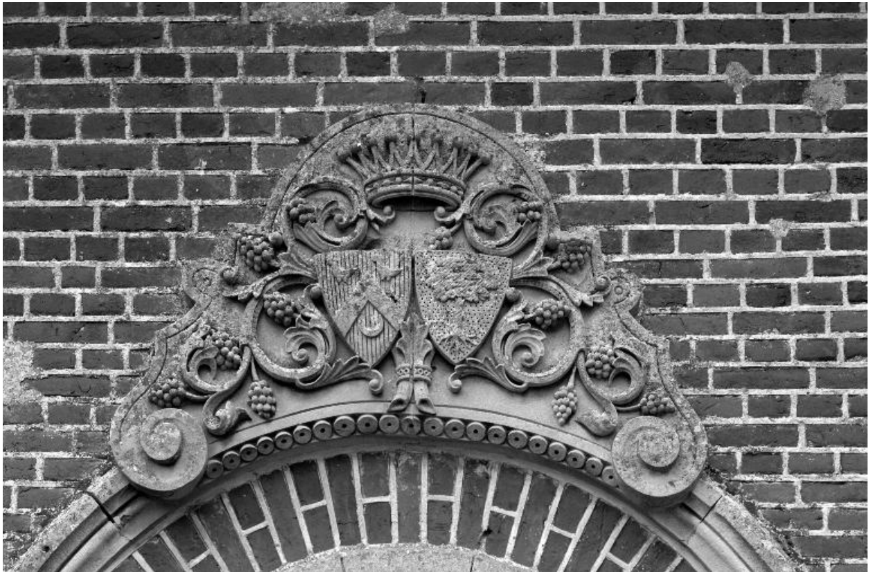
Détail de la porte ouvrant sur le bras nord du transept : armes des familles de Monclin et Dufresne de Beaucourt.
