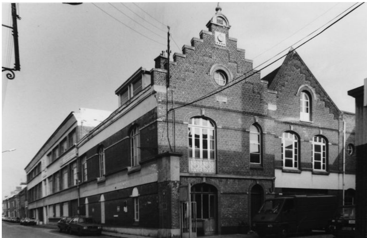
Vue des bureaux.
