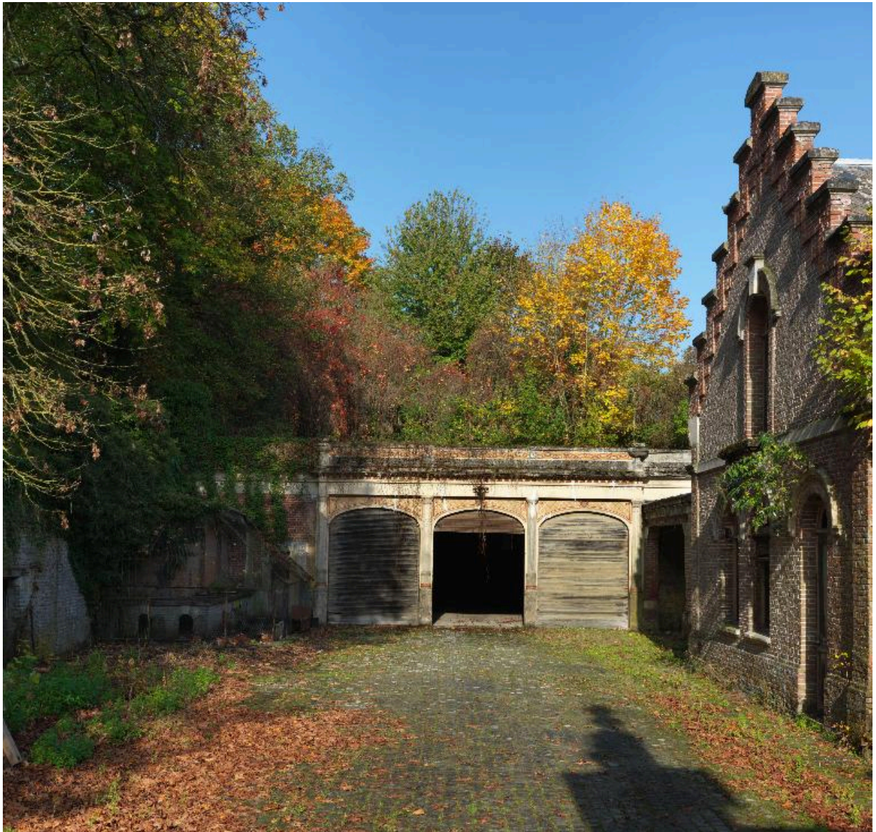
Le garage automobile, vue d'ensemble.
