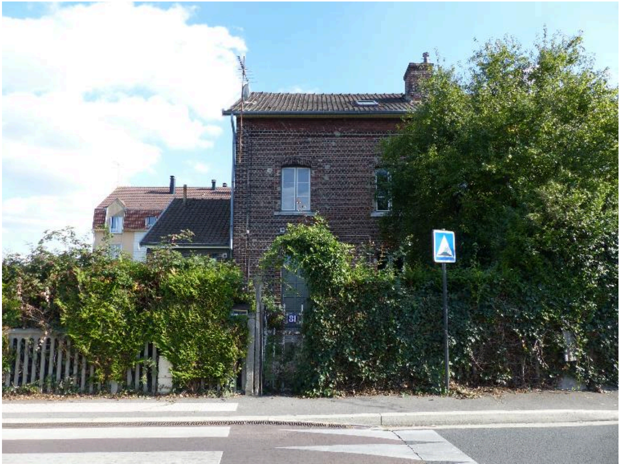
Maison de chef de train, rue Pierre-Sémard. Premières maisons de la cité construites vers 1910.
