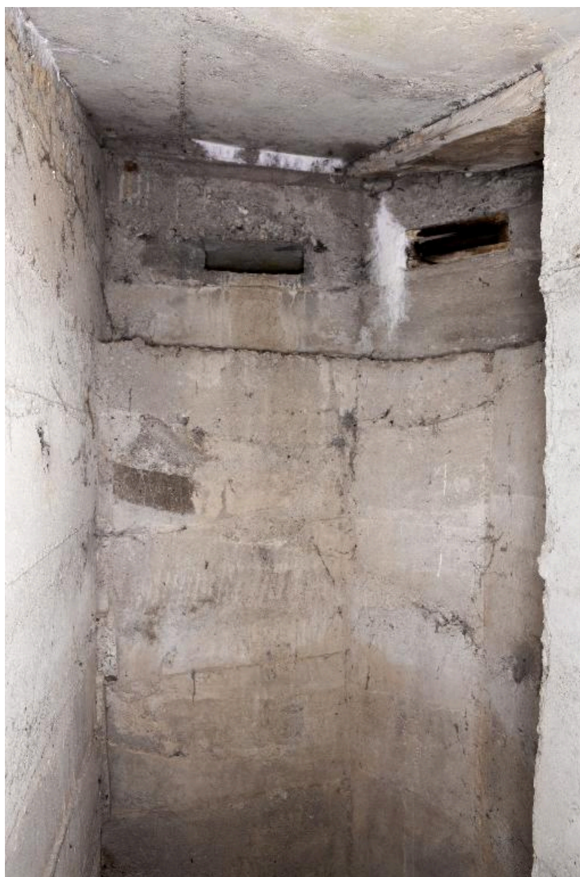
Vue intérieure de l'observatoire bétonné
