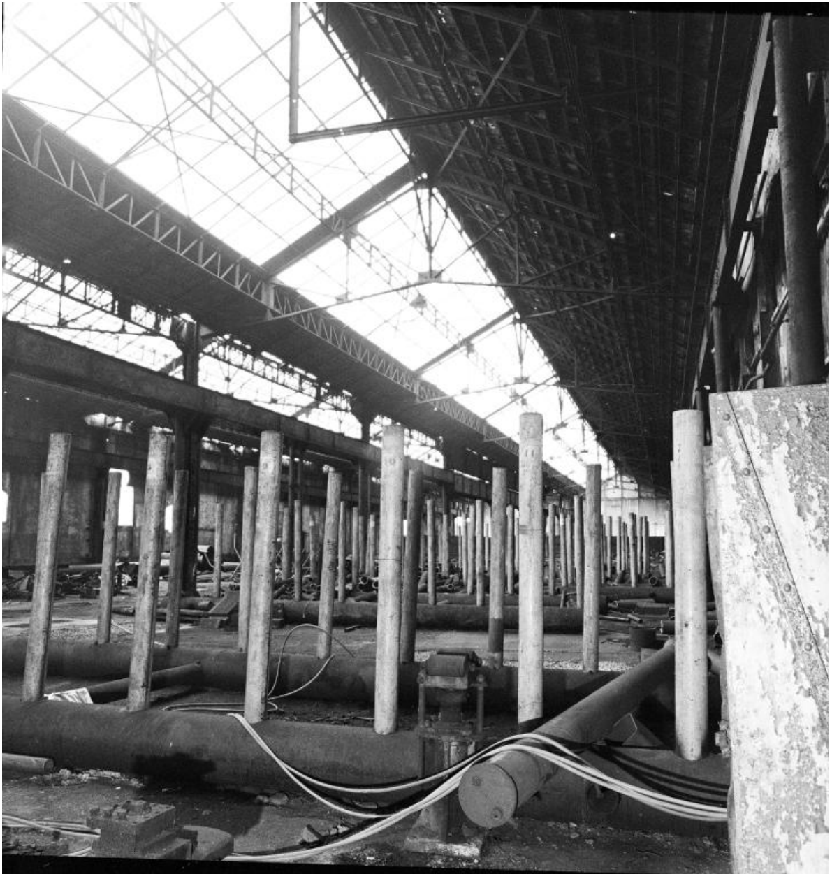
Aire de stockage des tubes (usine B).
