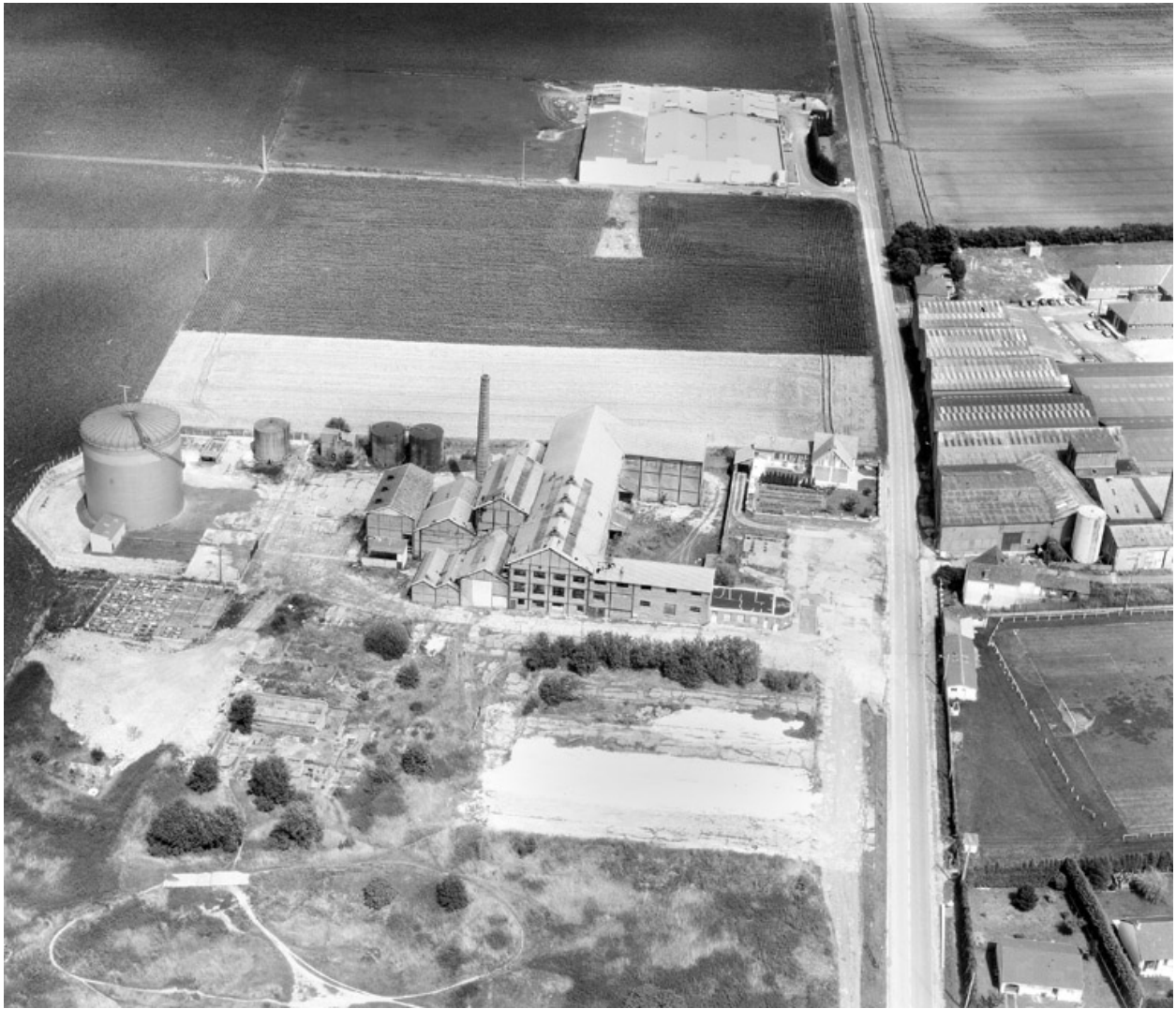
Vue aérienne, flanc ouest.
