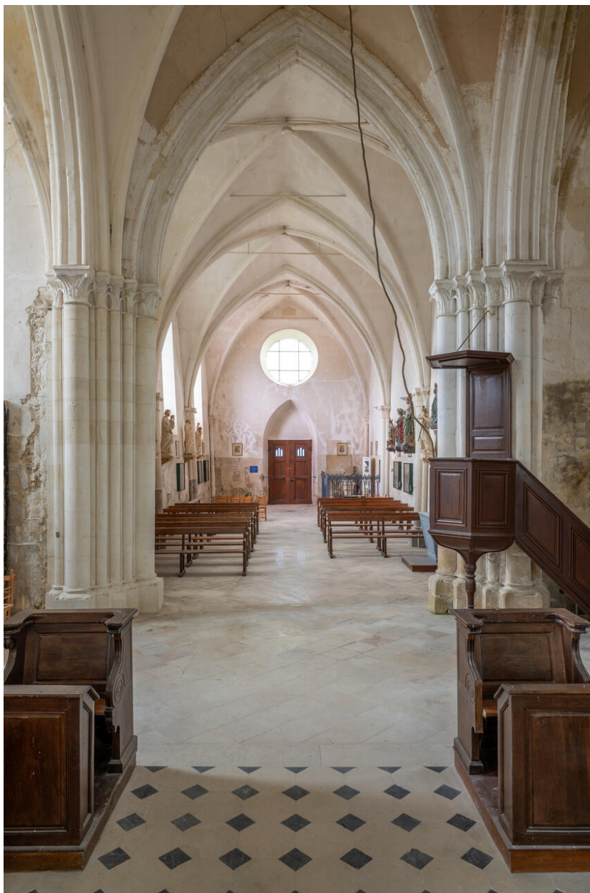
Vue générale vers la nef.
