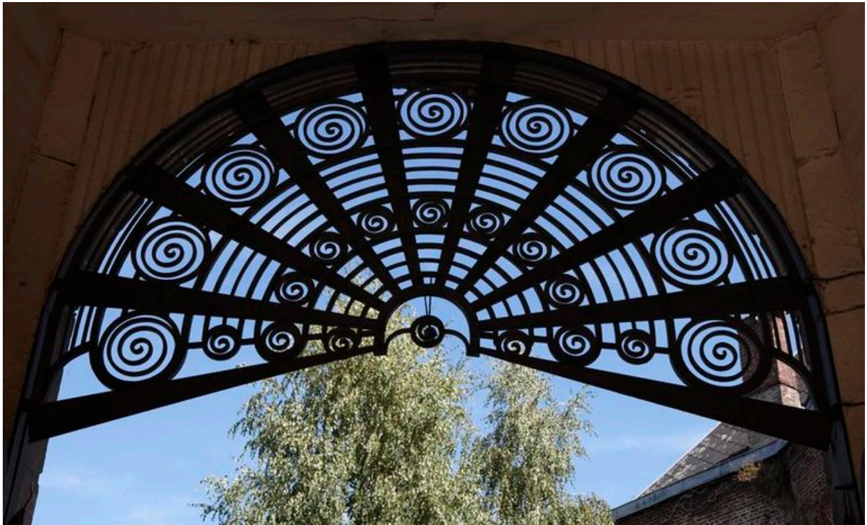
Vue de détail du couronnement de la porte cochère constitué de motifs en spirales.
