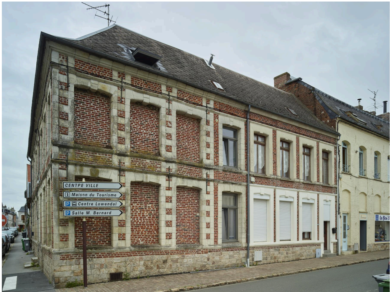
Façade rue du Général-Bouttiaux.
