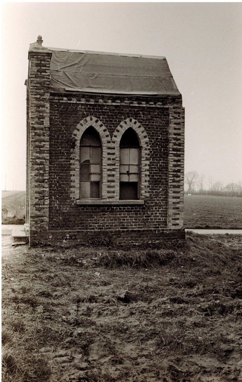
Côté sud de la chapelle en 1986, photographie, Comité de Sauvegarde des chapelles de Flandre (Comité Flamand de France).
