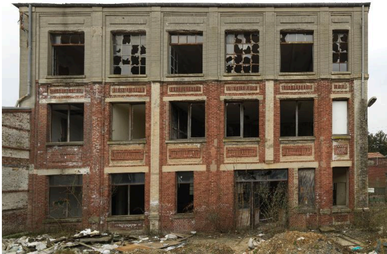
Façade postérieure du bâtiment principal sud.
