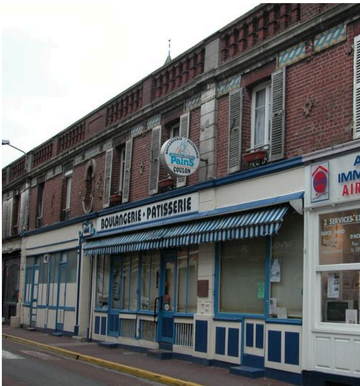
Détail d'une unité : 70, 72, 74, 78 et 78 rue Jules-Barni.
