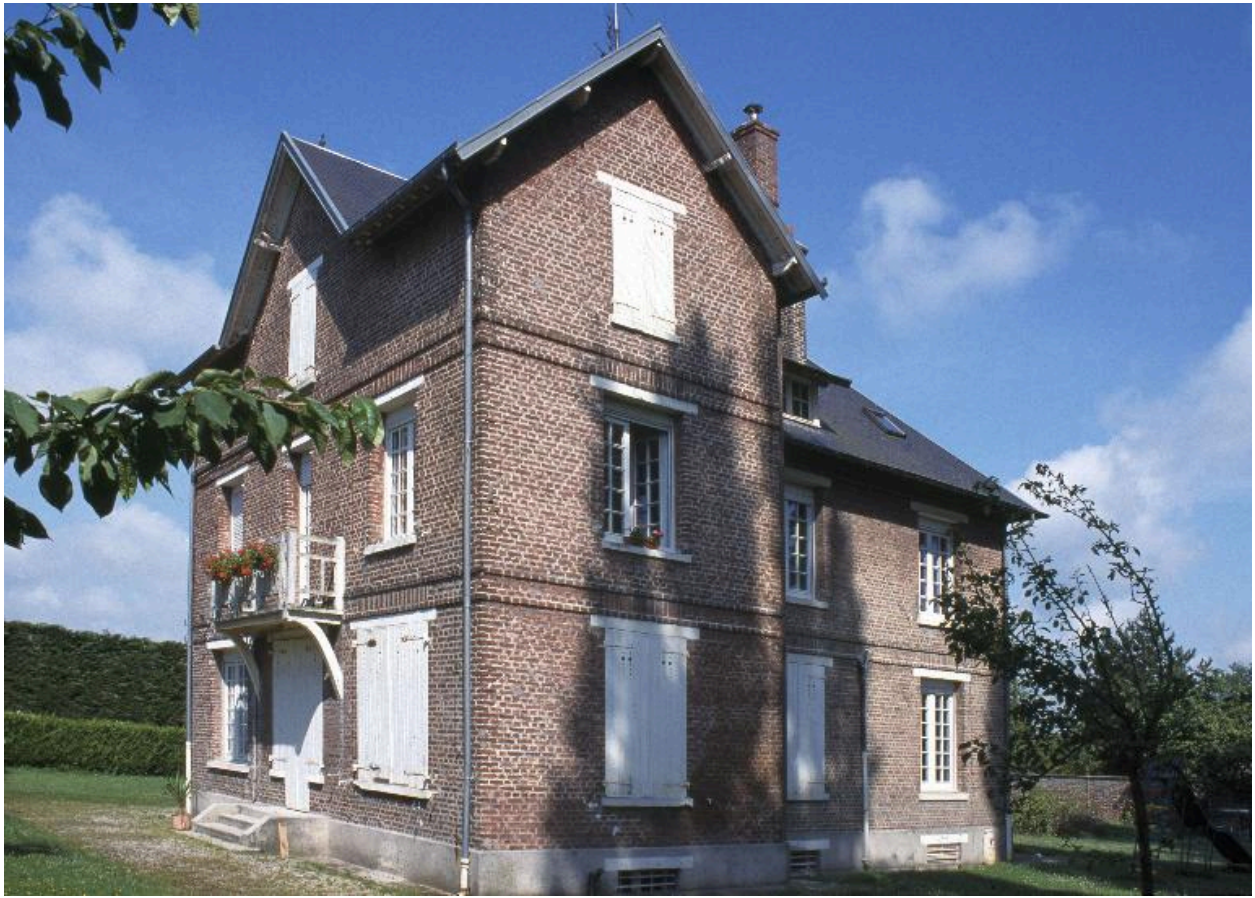
Vue d'ensemble d'un des logements de contremaîtres.
