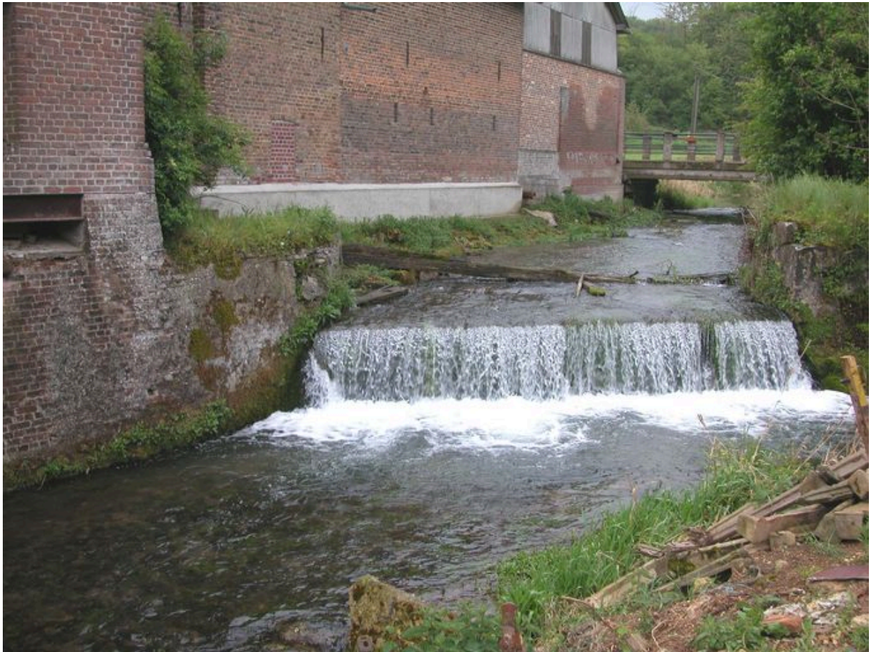
Les vestiges du vannage de décharge et la chute du moulin.
