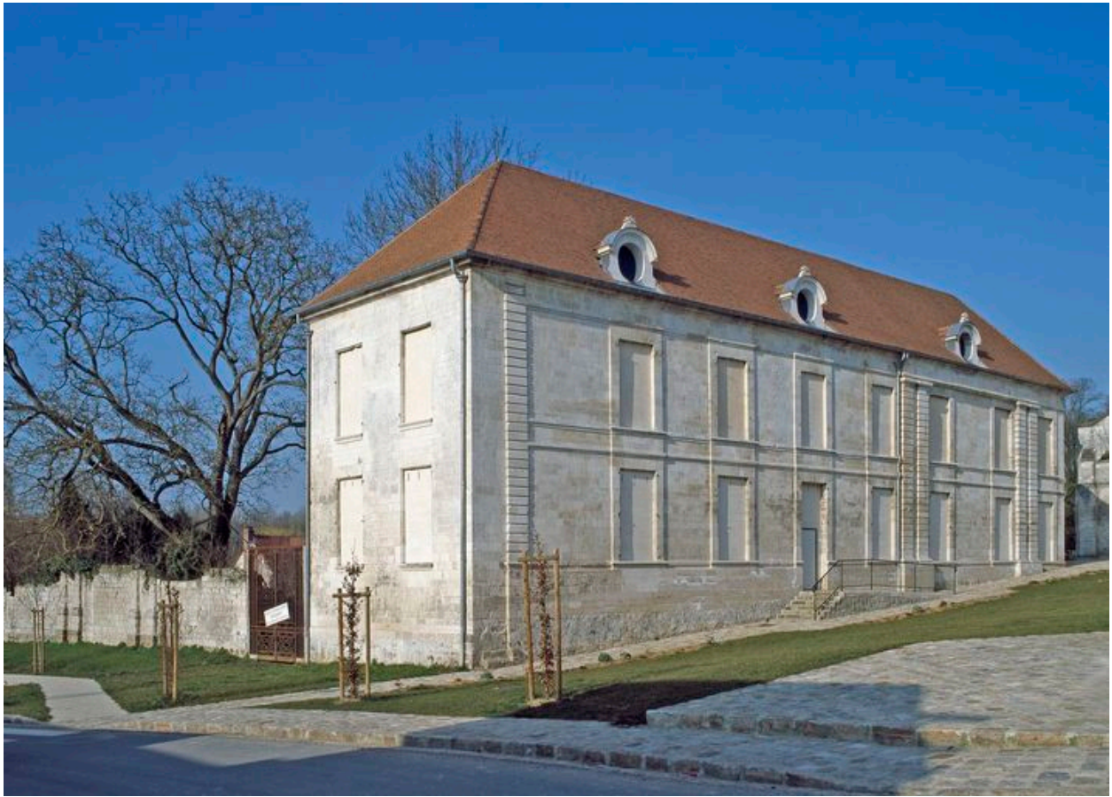
Façade principale de l'ancien logis abbatial.
