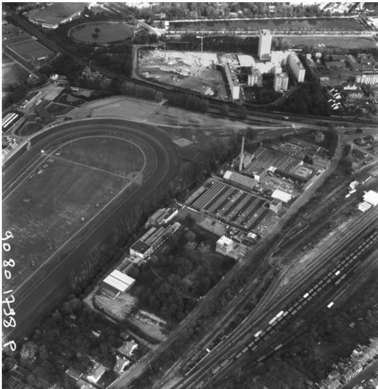
Vue aérienne, vue du sud.
