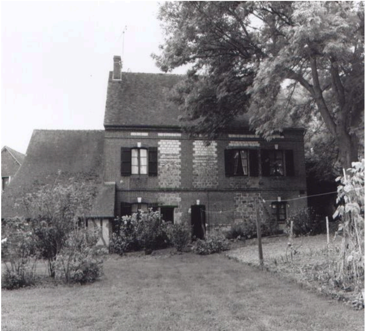
Façade postérieure de la maison d'habitation
