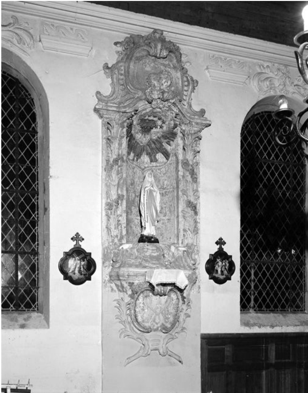
Détail d'une niche dans la nef, côté nord.
