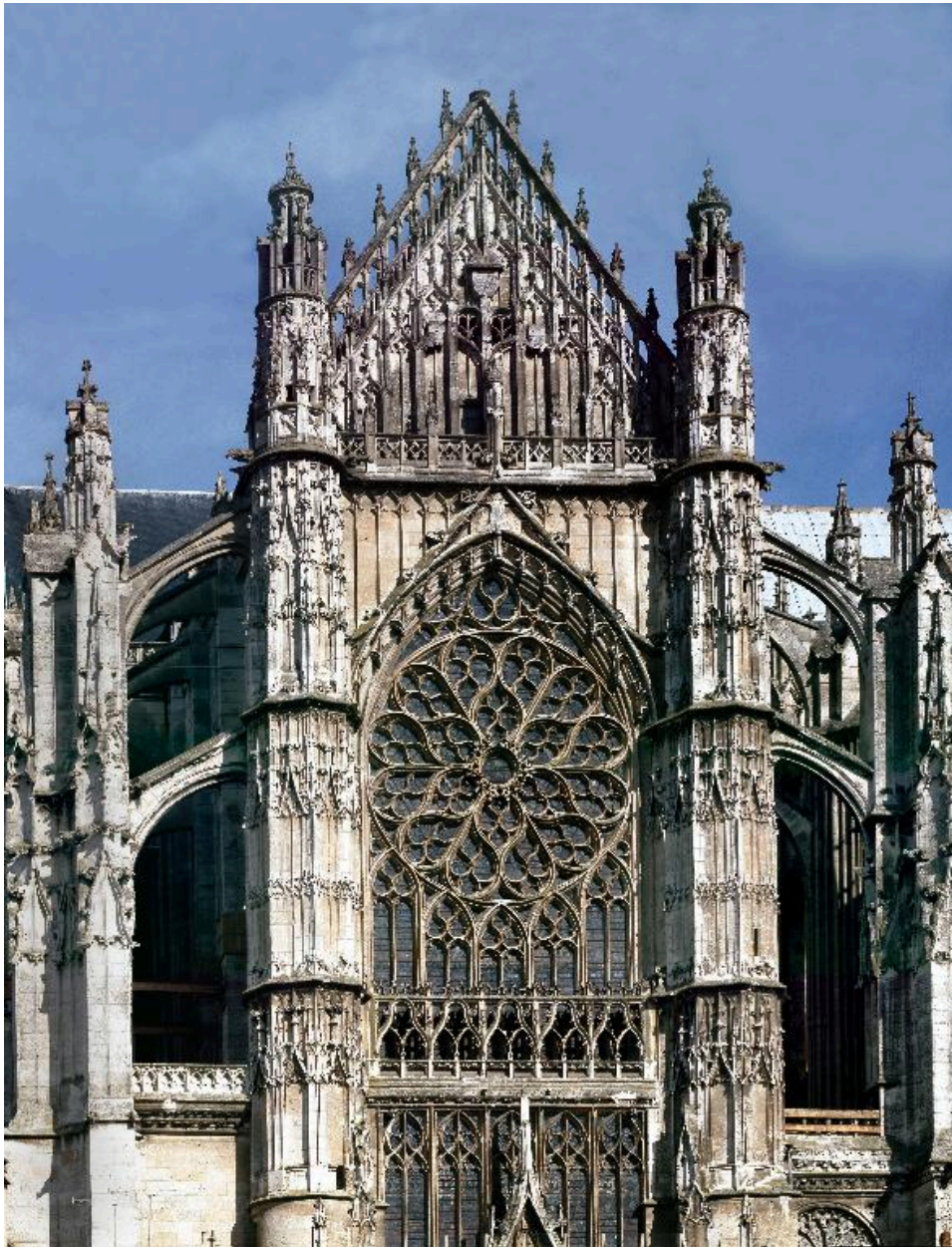
Vue de la façade sud du transept : partie supérieure (claire-voie, rose, gâble).
