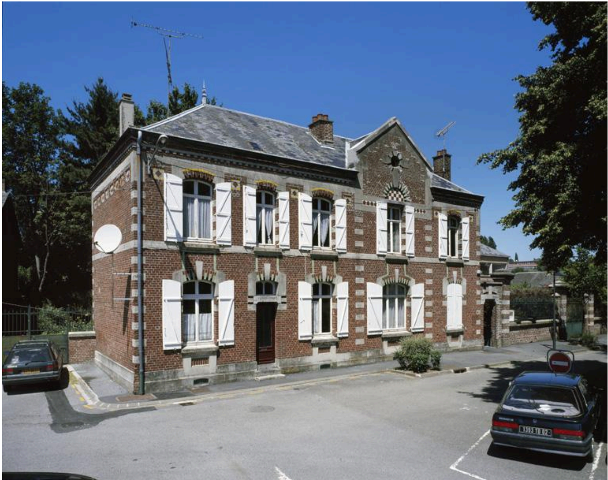
Vue du pavillon Ouest, abritant le logement de la directrice de l'école maternelle et de son adjointe.
