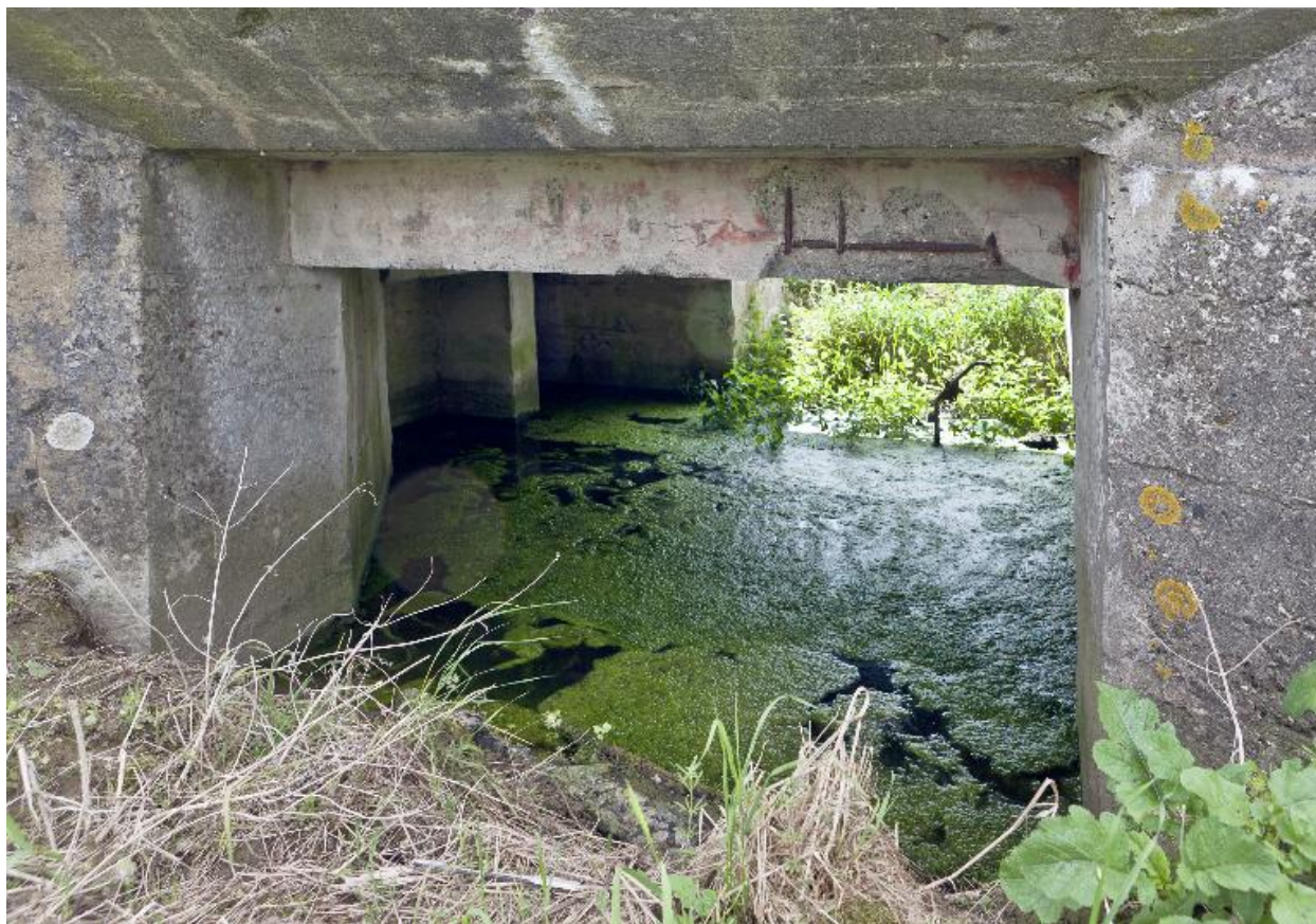
Sortie de la chambre de tir
