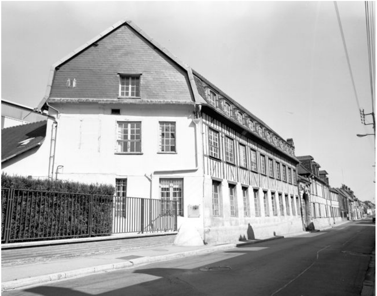
Vue latérale ouest est de la façade sud de la passementerie Gaitas.
