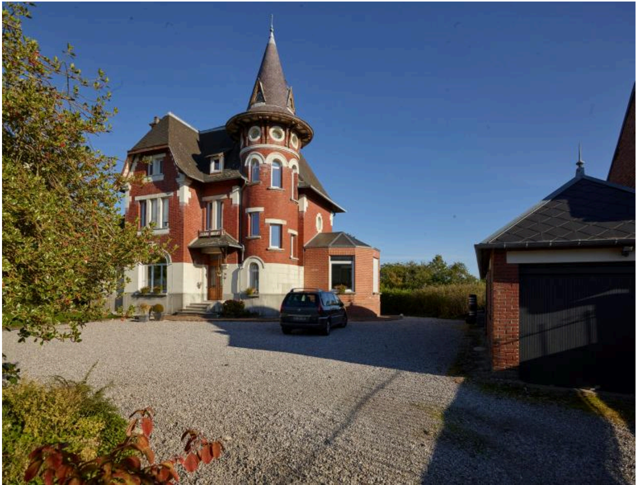
Vue générale avec le garage.
