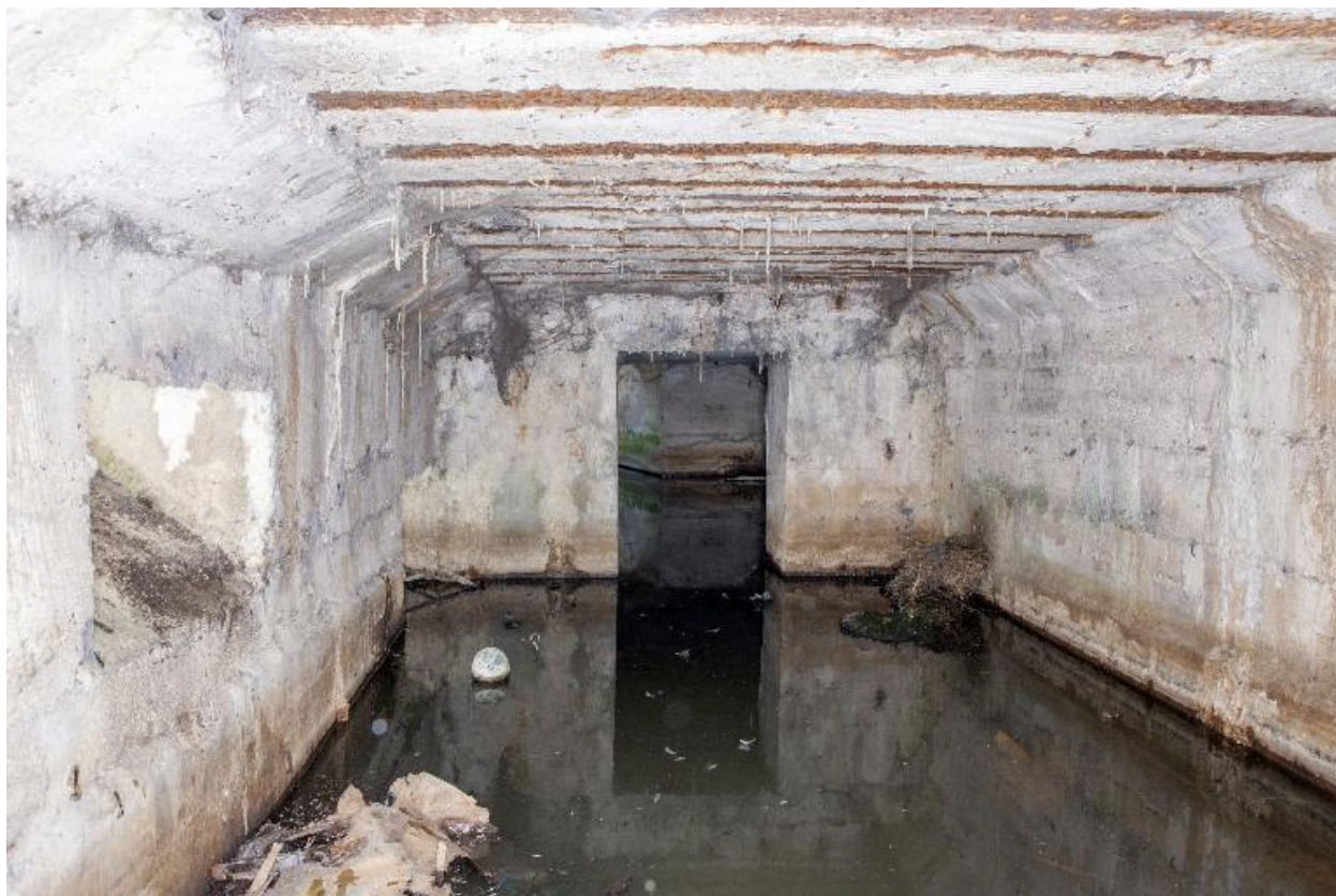
Vue intérieure en enfilade
