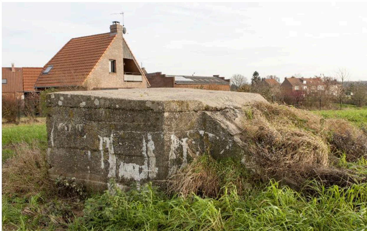
Vue de trois-quarts avant, vers le sud-est
