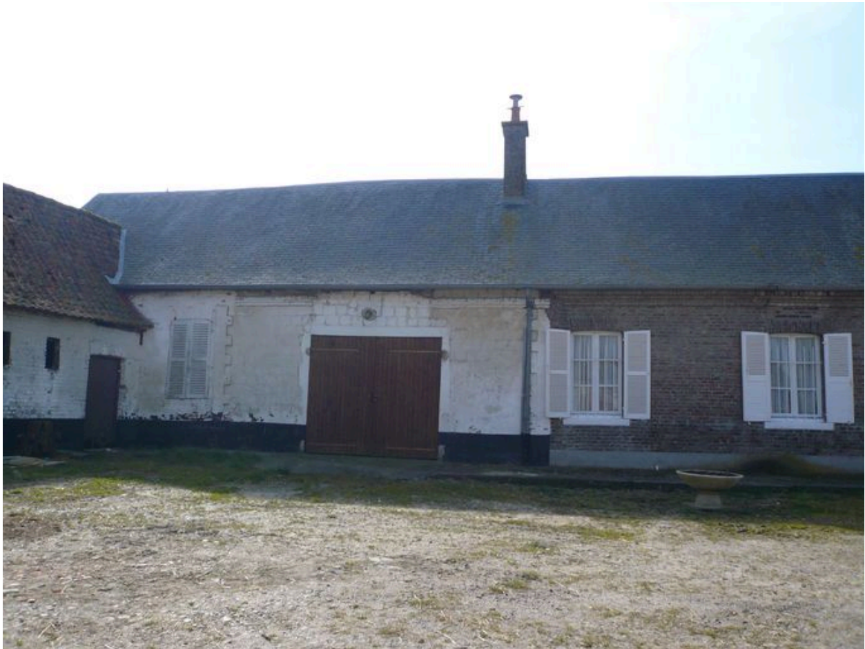
Vue de l'ancien logis en pierre de taille au sud-est de la cour.
