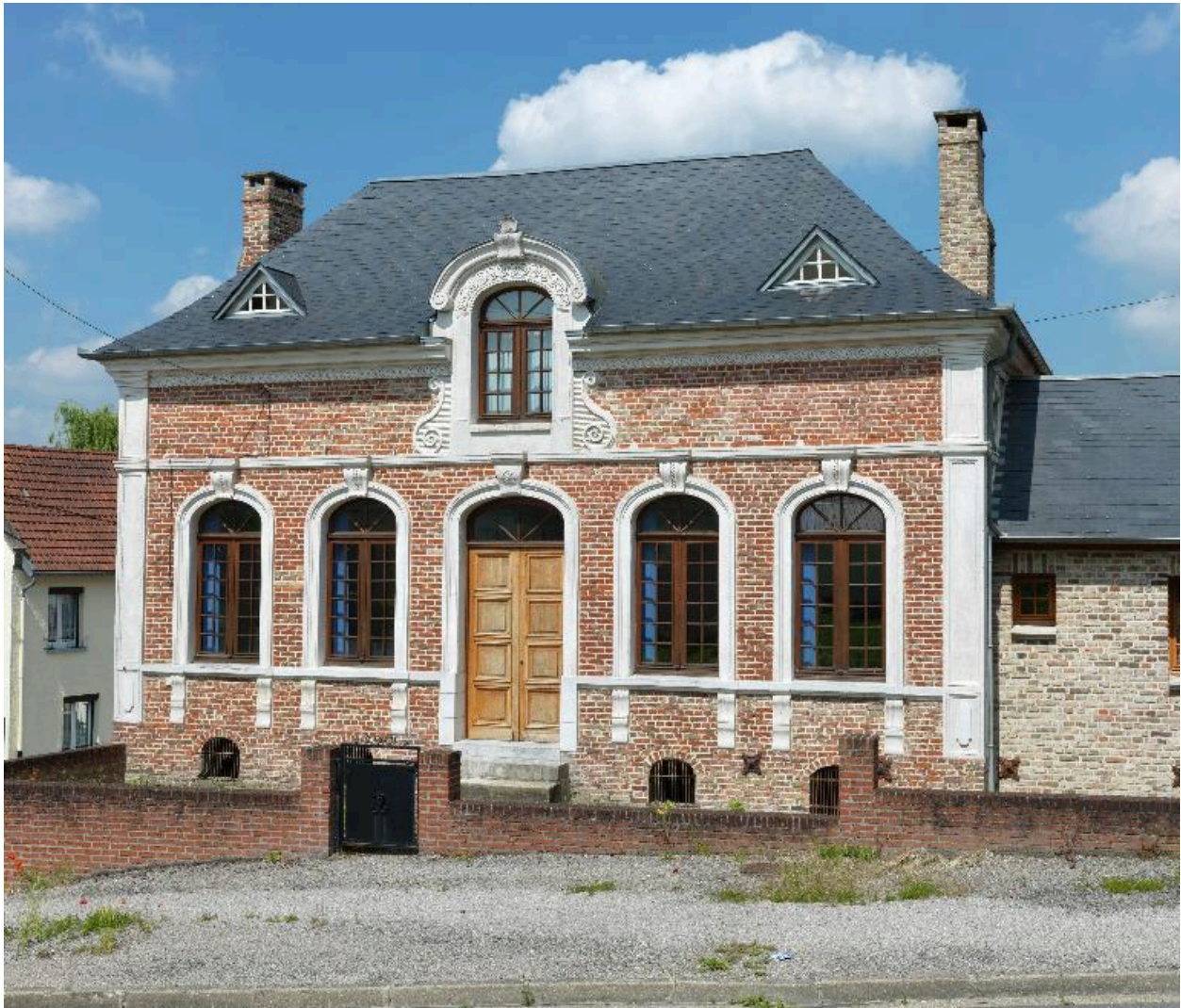
Façade sur rue, vue d'ensemble.
