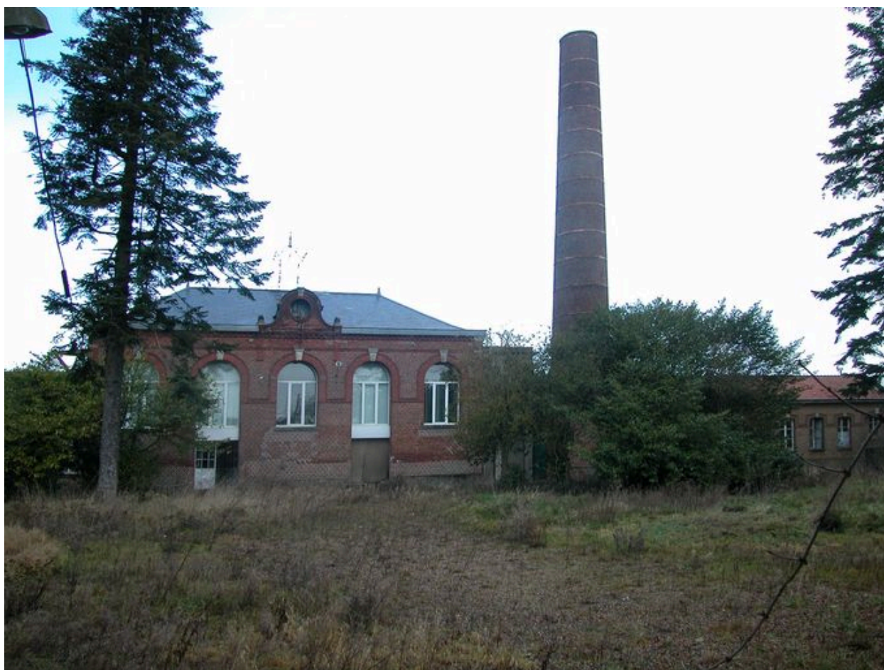
Vue générale depuis la cour.
