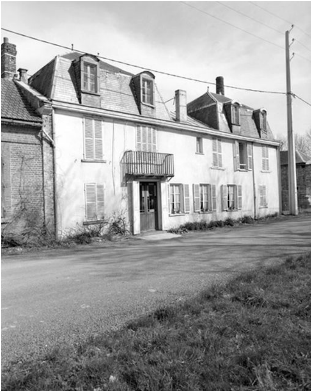
Logement patronal, élévation antérieure.
