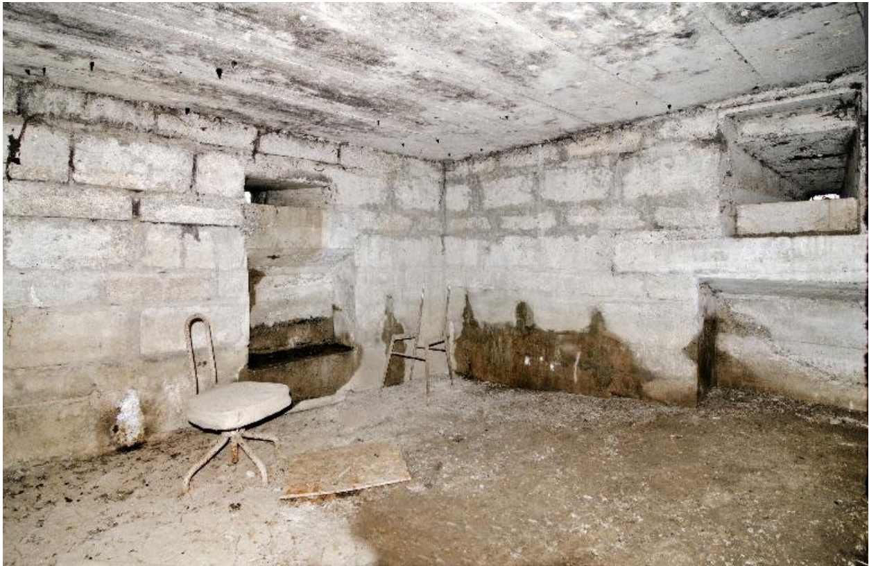
Salle nord, vers le nord-ouest. Niches et créneaux de fusillade
