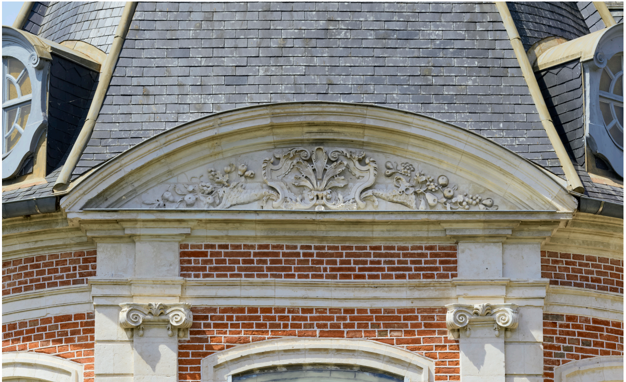
Façade sur jardin, détail du fronton cintré du pavillon sud.
