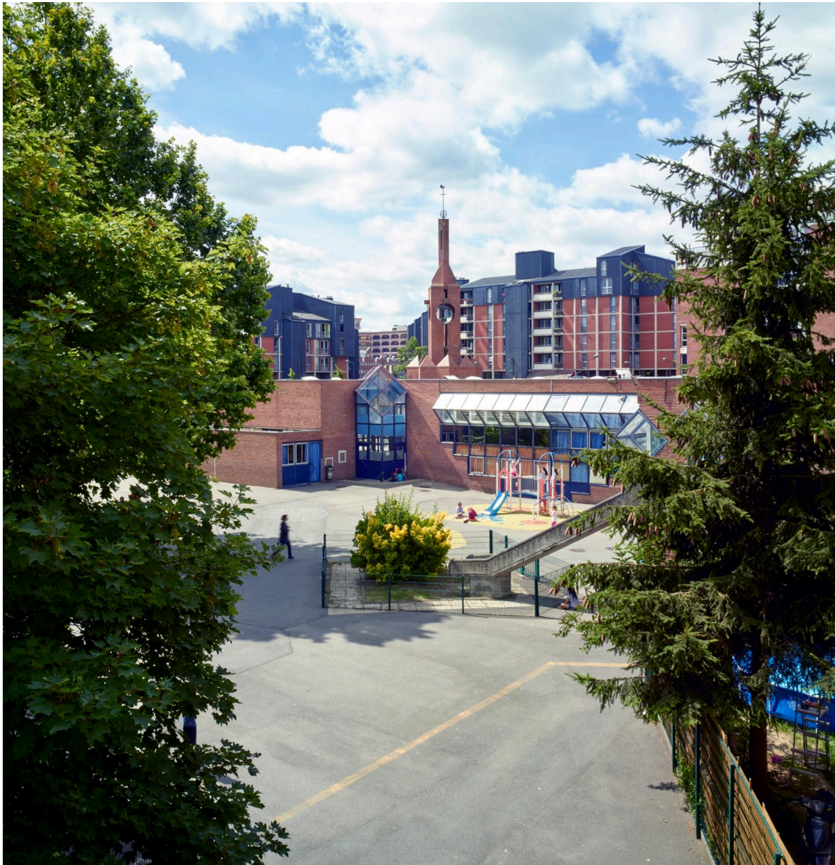
La façade arrière et la cour de récréation depuis l'îlot 15d voisin. Au fond la place de Venise et le clocher de la chapelle Saint-Marc.
