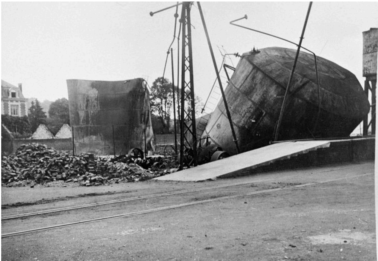
Les réservoirs de la sucrerie après l'explosion (AP).
