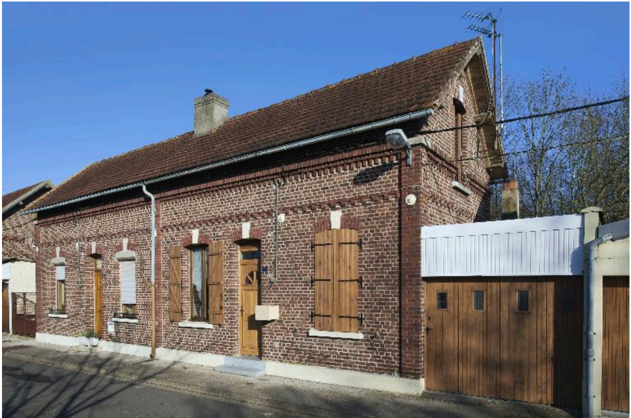
Vue de trois-quarts d'un groupe de deux logements de la cité ouvrière.
