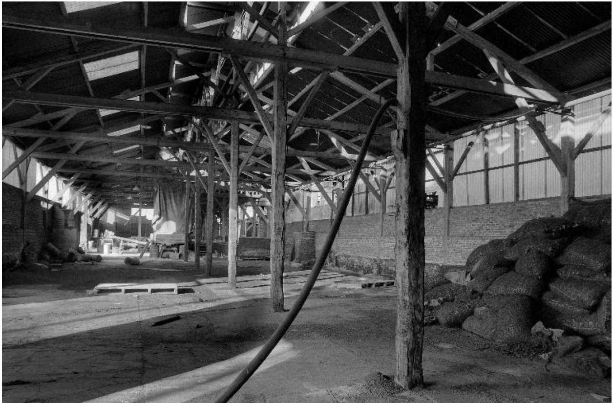
Magasin de stockage, vue intérieure.
