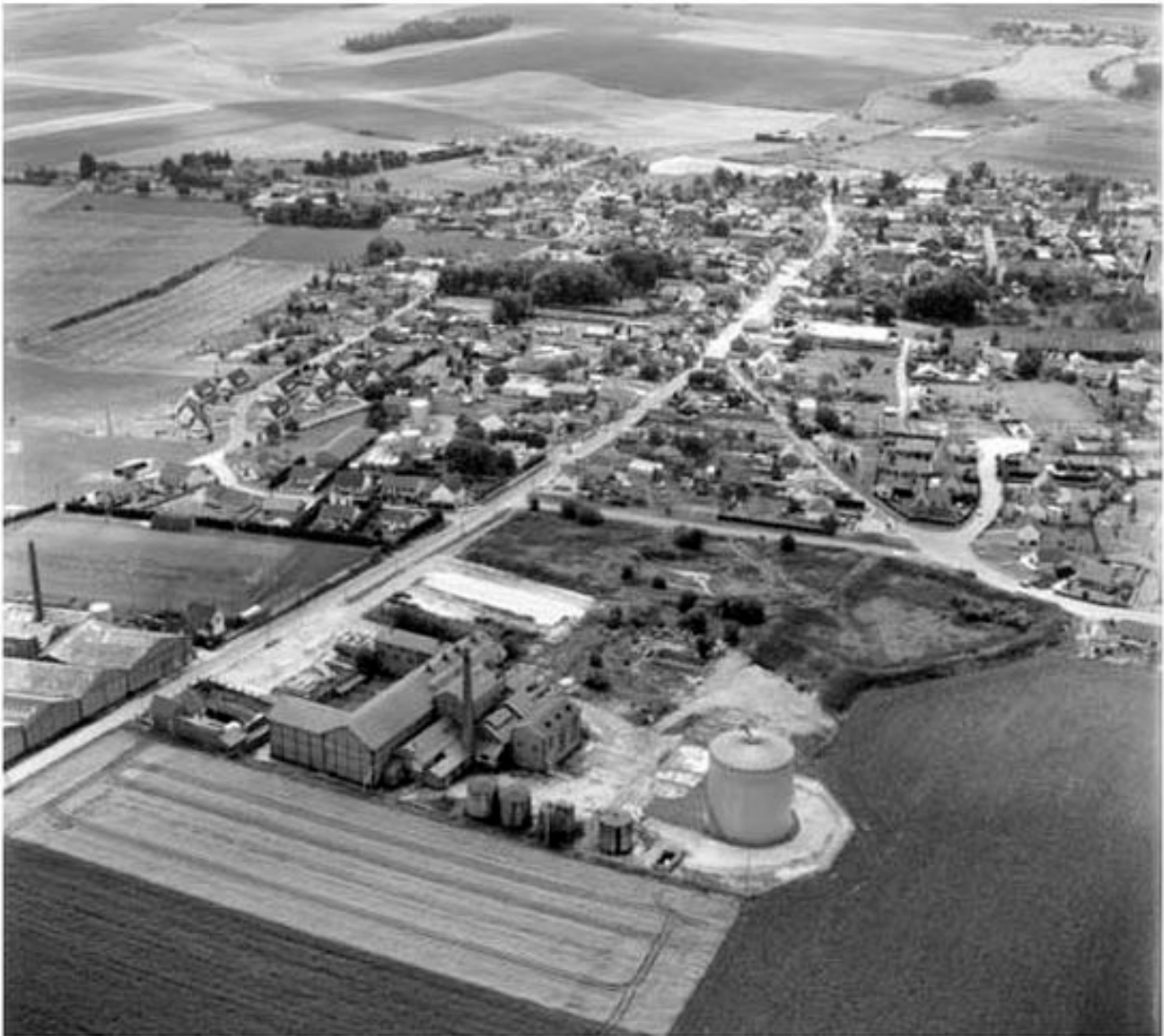
Vue aérienne, flanc est.
