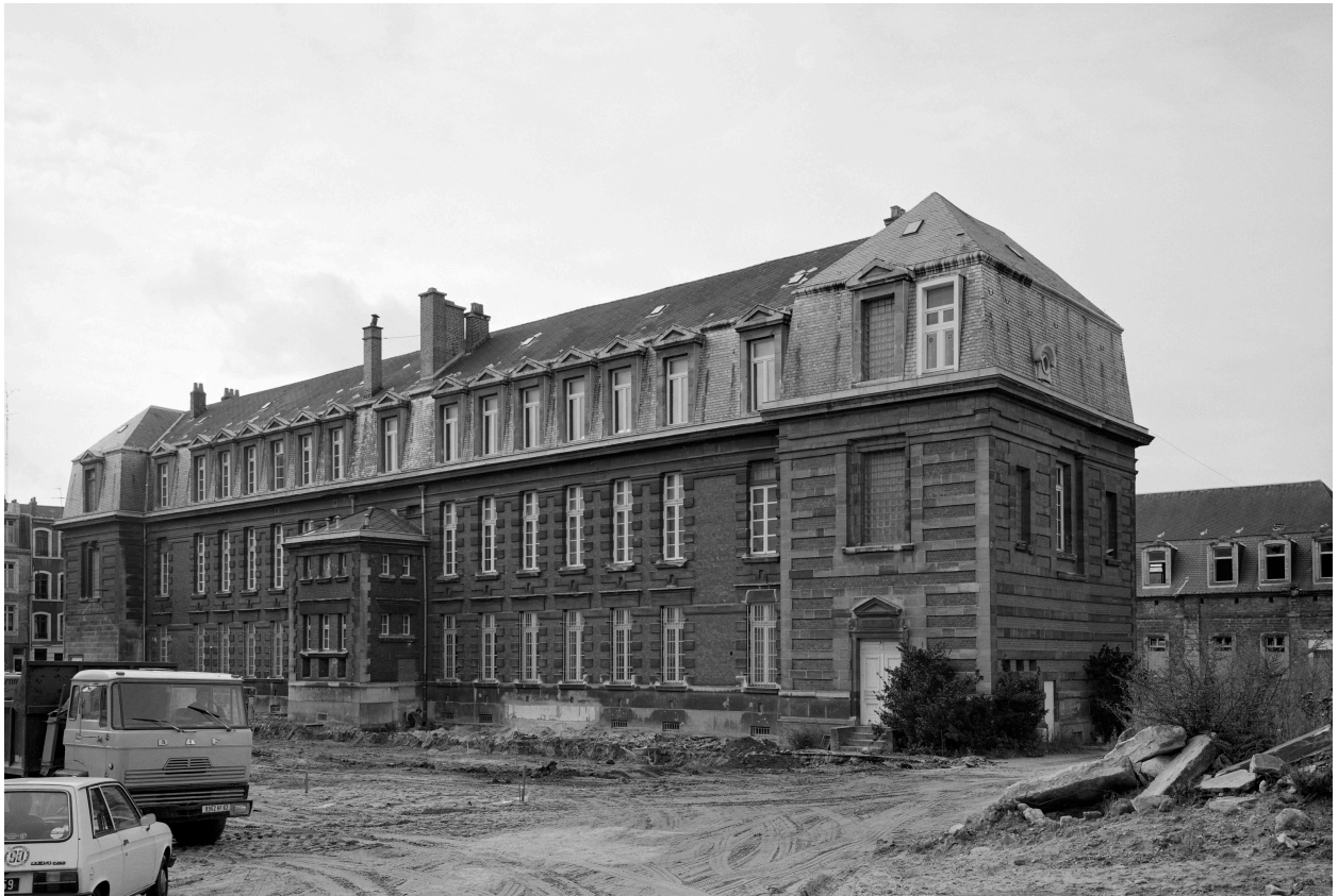
Vue d'angle nord.
