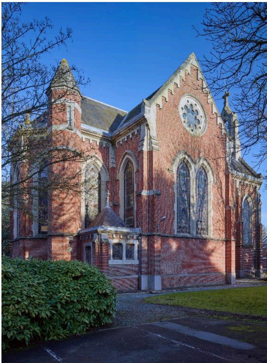
Chapelle, élévation nord, vue générale prise de trois quarts gauche.
