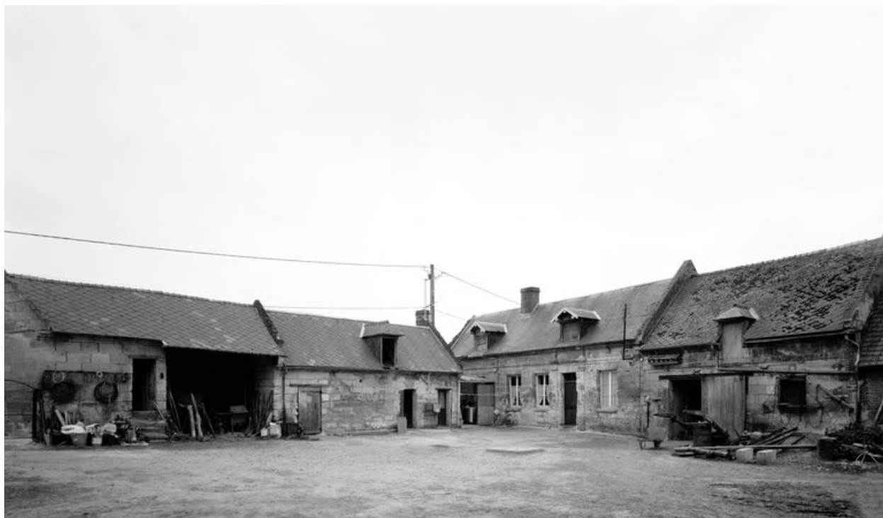
Vue des bâtiments sur cour.
