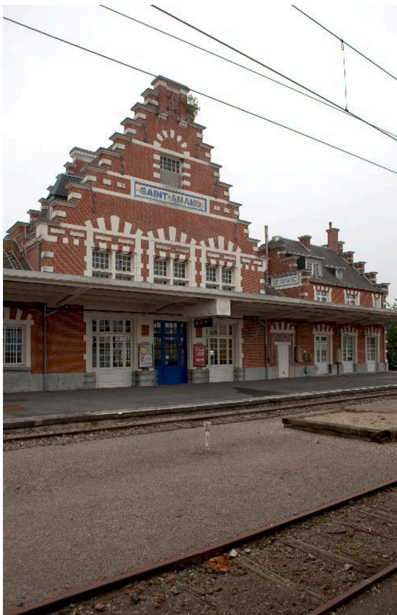
Vue générale de l'élévation postérieure.
