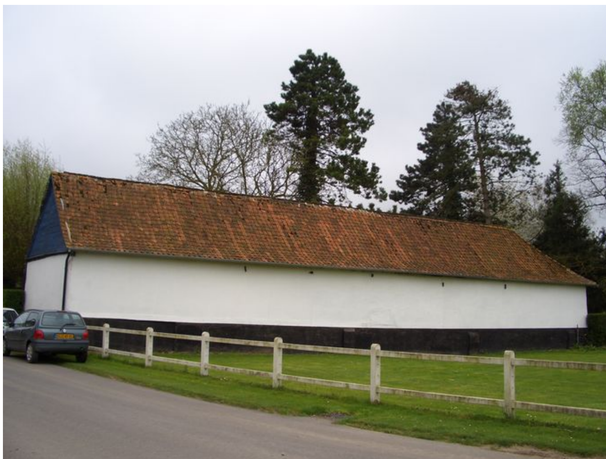
Vue postérieure depuis la rue du Marais.
