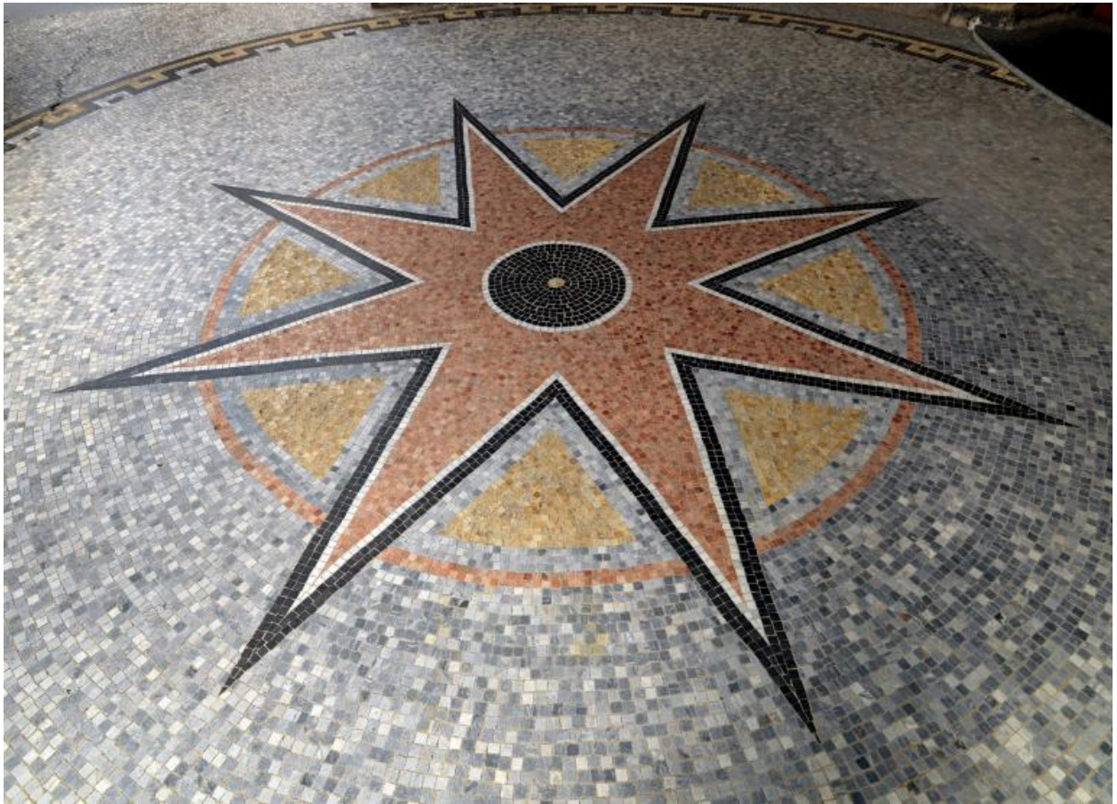
Détail du carrelage du porche.
