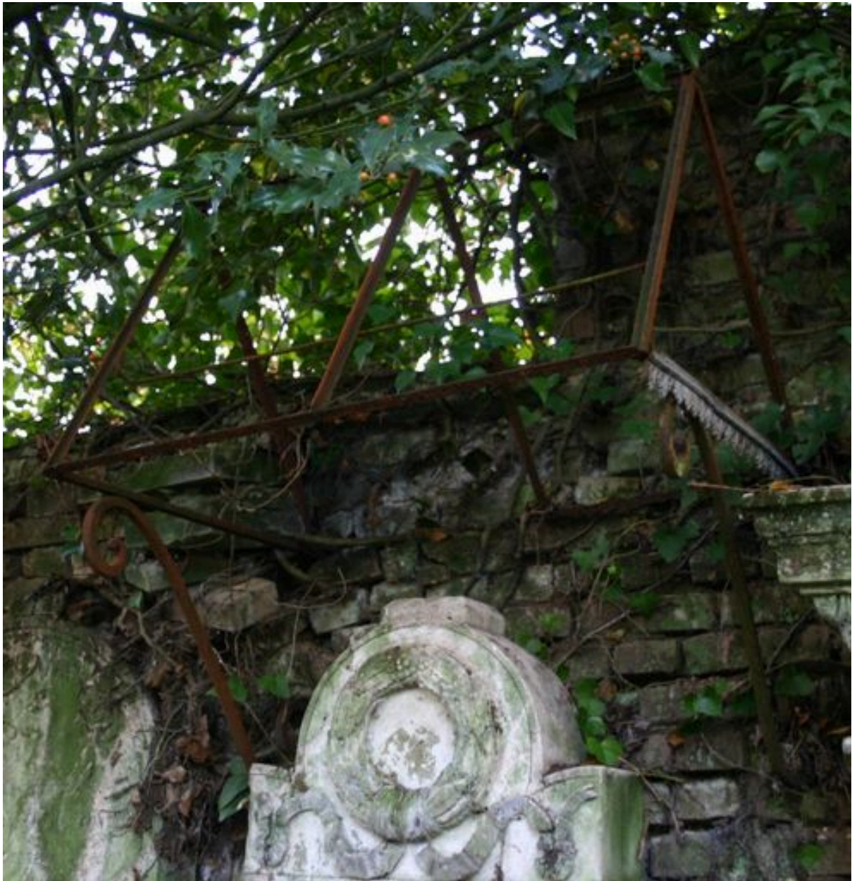
Armature métallique du petit auvent protégeant la stèle à fronton cintré.
