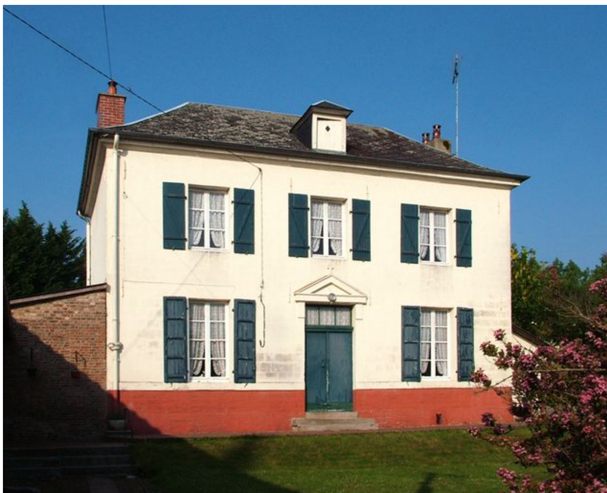
Façade sur cour.
