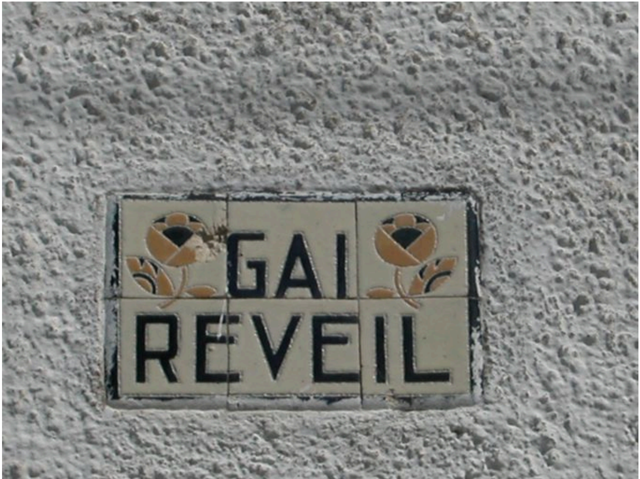
Détail du carreau de céramique portant appellation.
