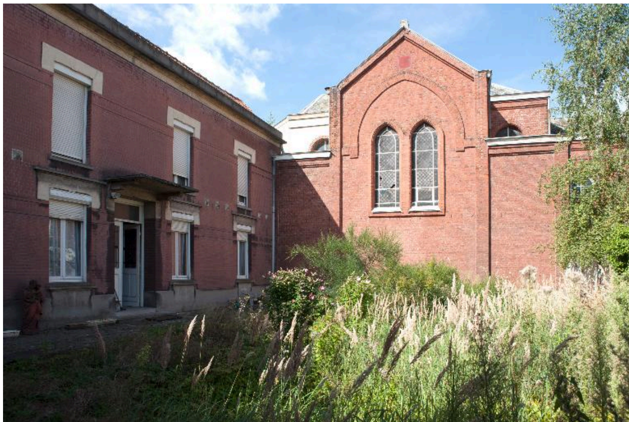
Le logis des soeurs et la chapelle.
